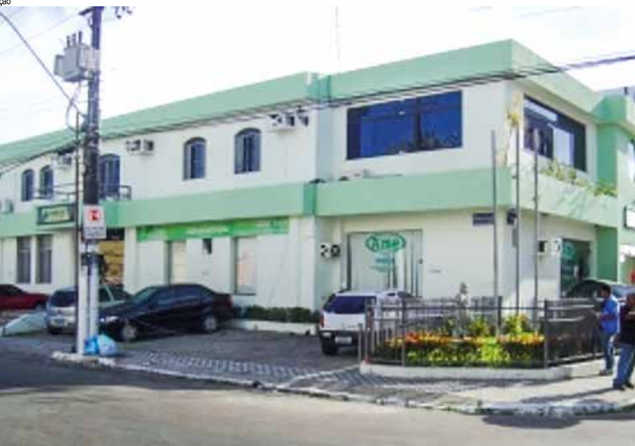
A Somese participou da criação do Sindimed/SE, da instalação do Cremese e apoiou, também, a fundação da Unimed Aracaju
